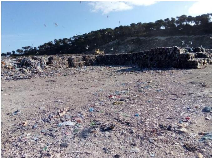
Se pasa de trabajar con compactador de pisonos a pala cargadora provista de pinzas para la colocación de las balas.
