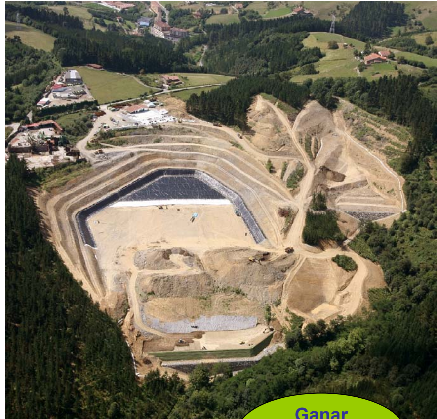
Obra nuevo vertedero de RNP (agosto-08)
