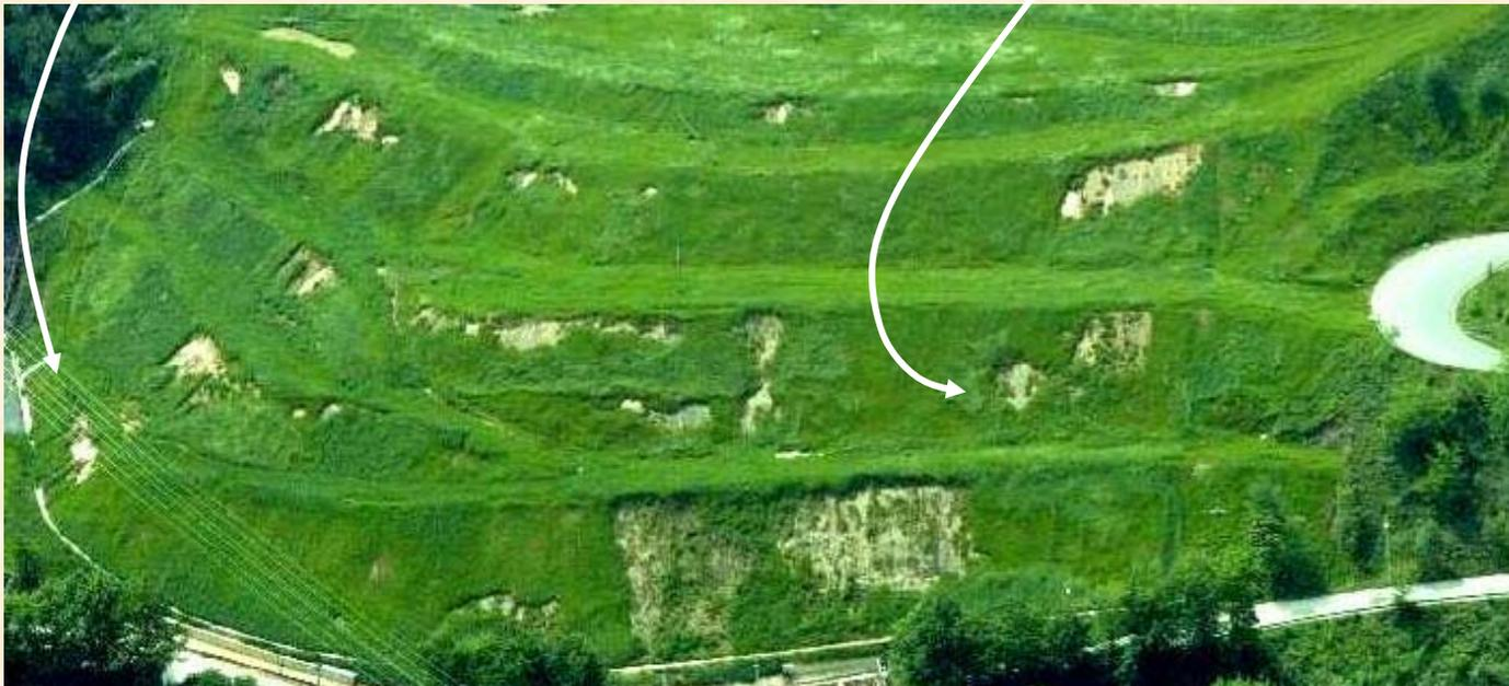
Solución tipo: se forman una serie de bermas en el talud del vertedero con una altura entre 10 - 20 m y una pendiente entre 3H:1V y 2H:1V
