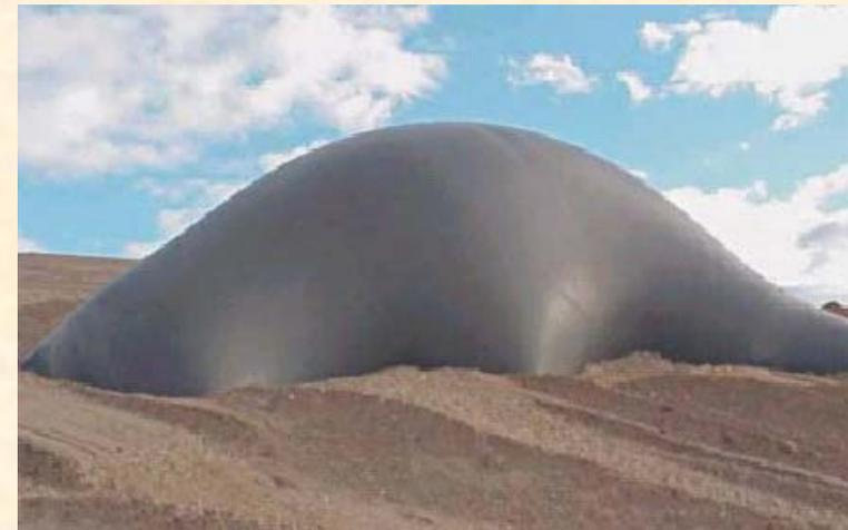
Geomembrana inflada por el gas (Richardson et al., 2008)
