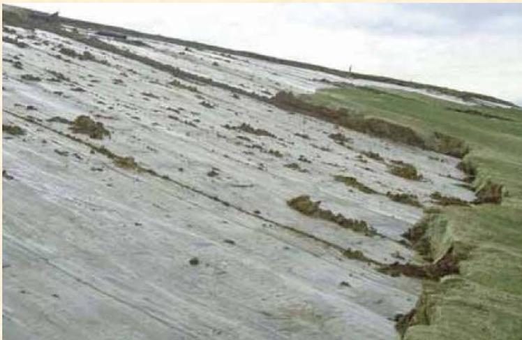
Deslizamiento causado por la subpresión del gas
