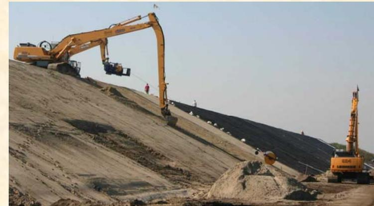
Extensión de materiales mediante retroexcavadoras de brazo largo y compactación mediante rodillos remolcados
