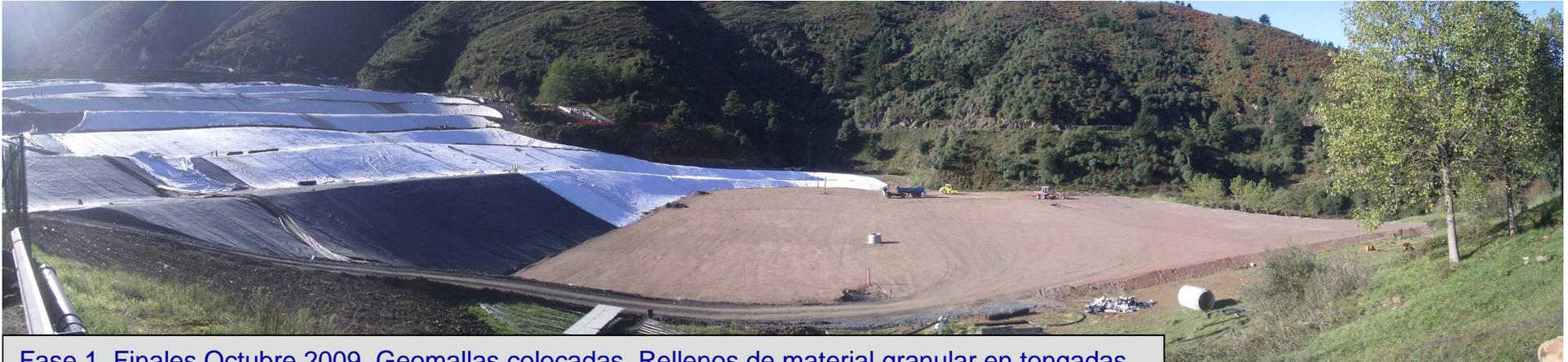
Fase 1. Finales Octubre 2009. Geomallas colocadas. Rellenos de material granular en tongadas
