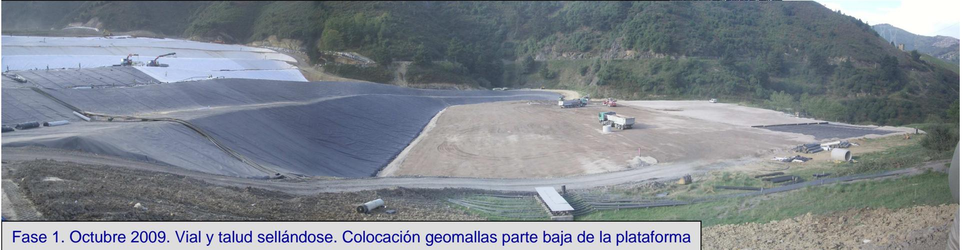
Fase 1. Octubre 2009. Vial y talud sellándose. Colocación geomallas parte baja de la plataforma
