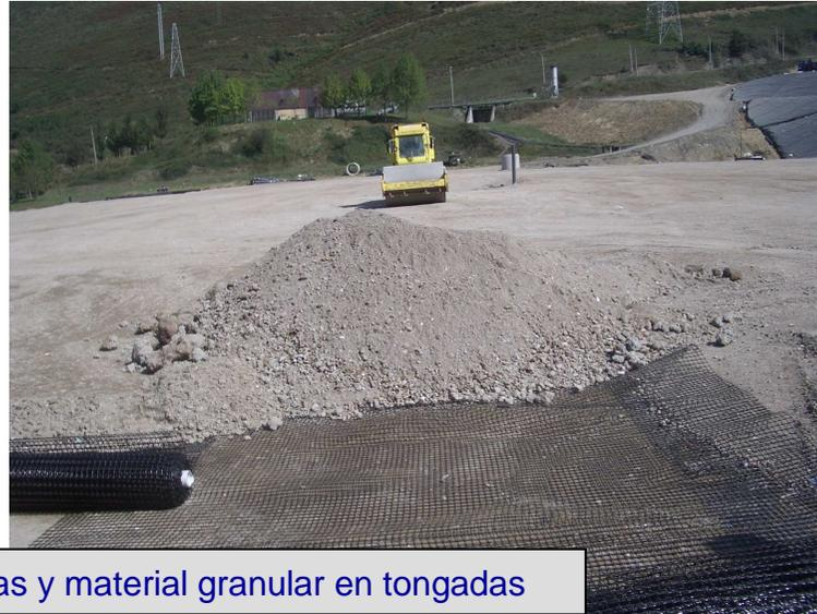
Fase 1. Septiembre 2009. Detalles colocación geomallas y material granular en tongadas
