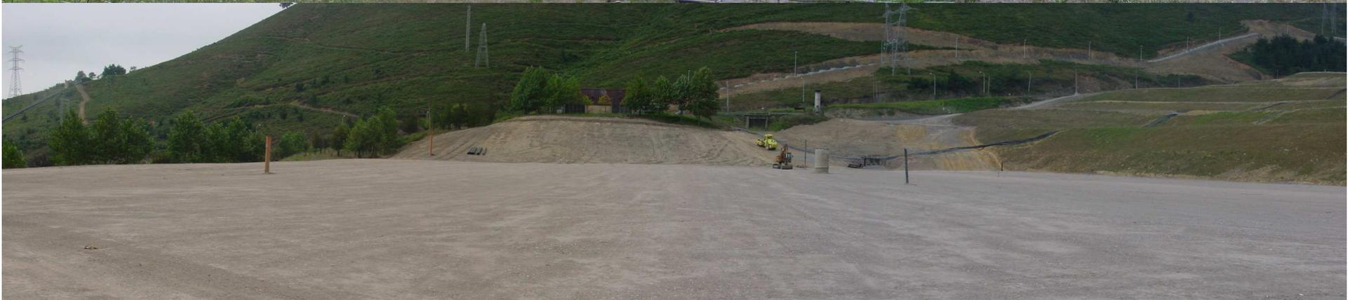
Fase 2. Agosto 2010. Retirada de Precarga Terminada. Formación Superficie de Conformado en plataforma y talud noreste
