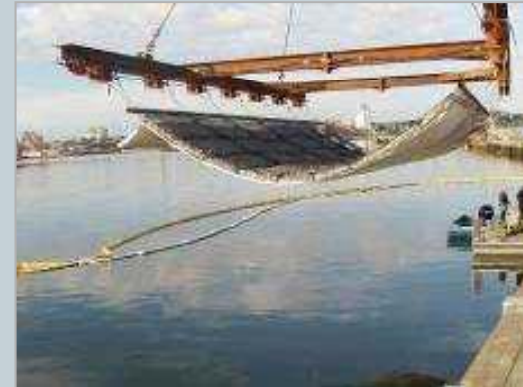
Manta de Gaviones
