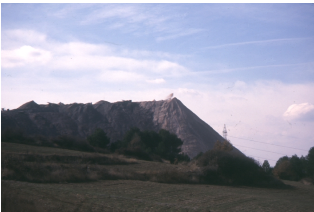
Foto 1.2. Escombrera construida mediante vertido directo.
