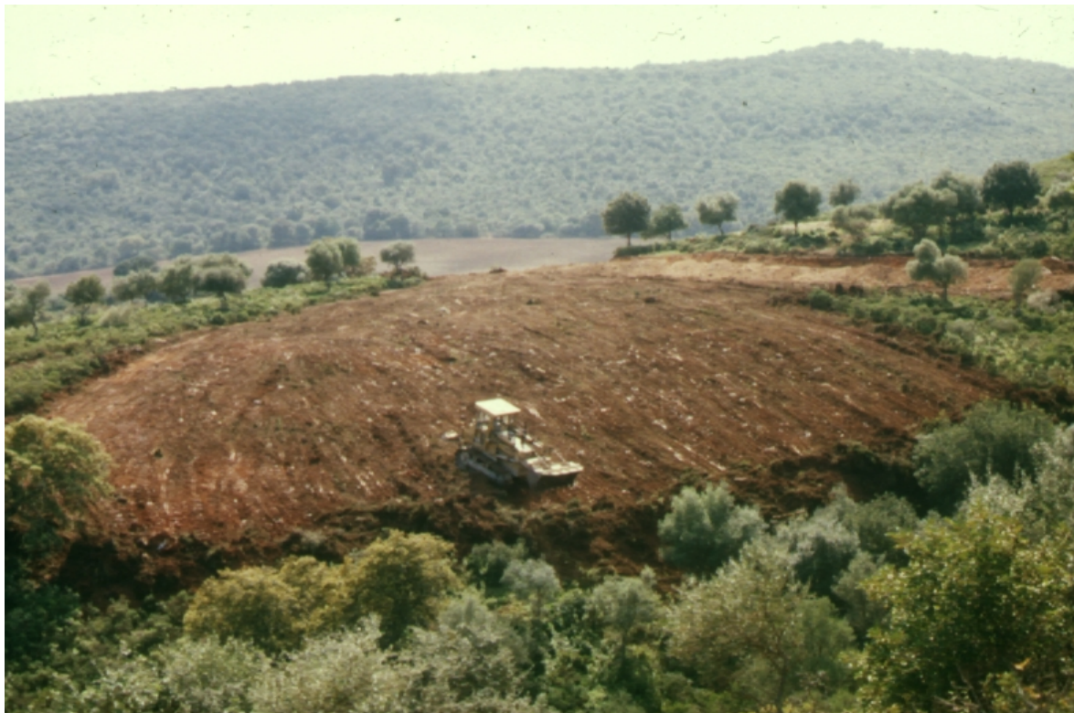
Foto 4.1. Retirada de la vegetación y suelos de recubrimiento para la construcción posterior de una escombrera.
