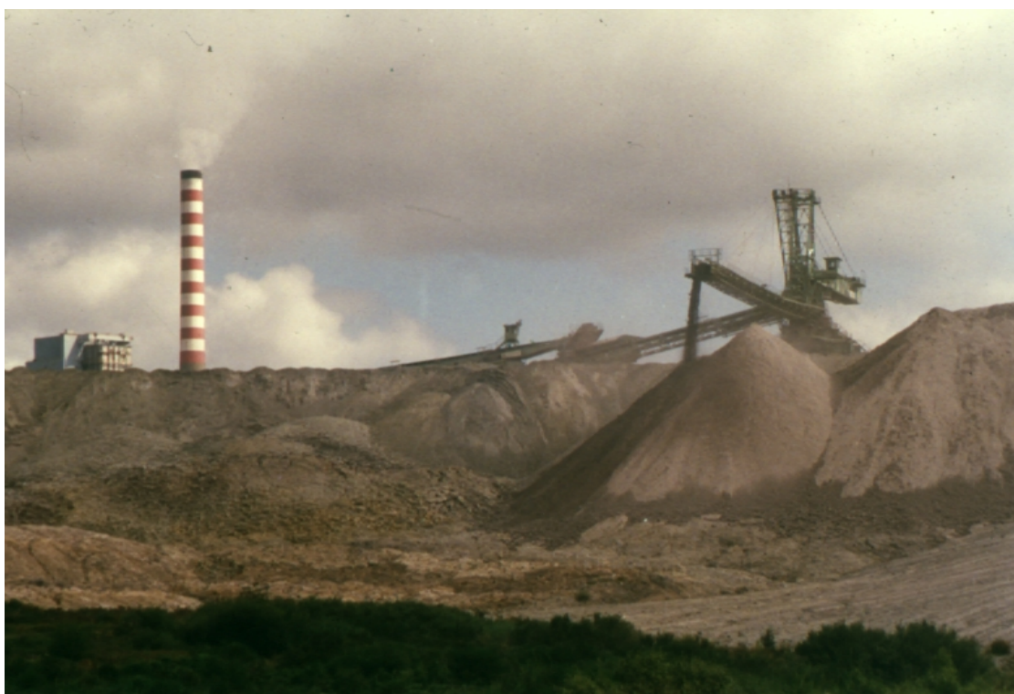
Foto 4.2. Construcción de una escombrera con apilador.
