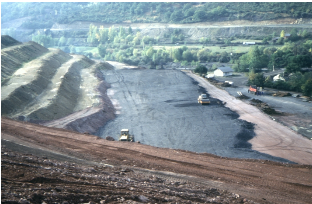
Foto 5.3. Construcción de una célula con estériles extendidos y compactados.
