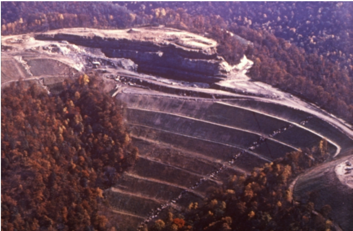
Foto 1.1. Escombrera de vaguada.
