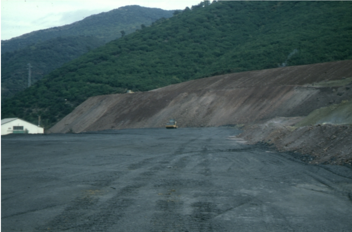
Foto 5.2. Recubrimiento del talud de una escombrera con estériles rojos.
