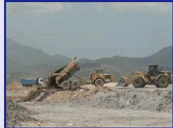
Taludes conformados con pendientes 2,5H:1V (40%) y compactados al 95 % PN
