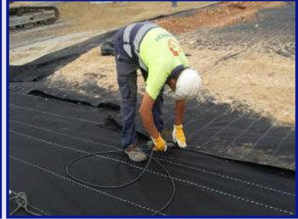
Instalación y anclaje del Enkamat 7010W/5/200.50 PET (10 mm)
