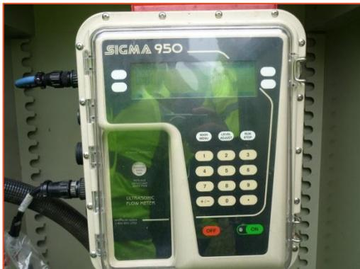
*Fotografías 15a y b.- Caudalímetro para el control de lixiviados y sistema de registro*
