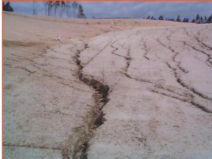
*Fotografía 6.- Huellas de la escorrentía superficial producida en un talud no impermeabilizado por encima del acúmulo de residuos*
