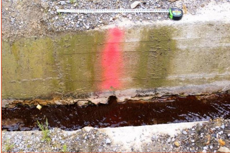
*Fotografía 18.- Punto de fuga en una conducción de lixiviados. En este caso el punto se sitúa justo antes del caudalímetro de control por lo que esta pérdida interviene en el balance hídrico*
