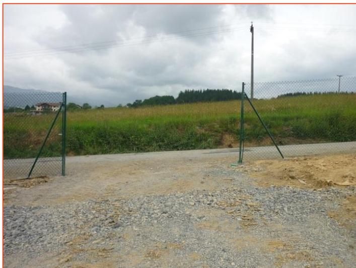
Fotografía 7.- Posible lugar de entrada de escorrentía de urbanización externa debido a la falta de cunetas o sistemas que independicen hidráulicamente el vaso de vertido. La zona de entrada de los viales de acceso al vaso de vertido constituye habitualmente un punto susceptible en este sentido.
