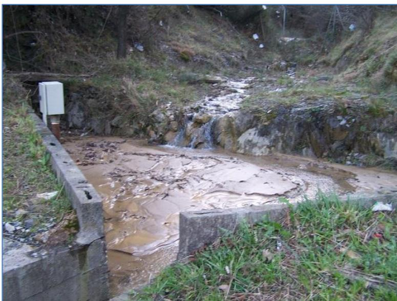
*Fotografía 5.-- Captación-desvío de un arroyo entrante en un vertedero hacia los canales perimetrales*
