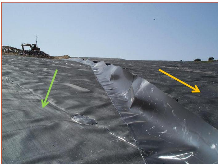
*Fotografía 3.- Rain-flap dispuesto en la impermeabilización de fondo para separar hidráulicamente sectores dentro del vertedero.*
