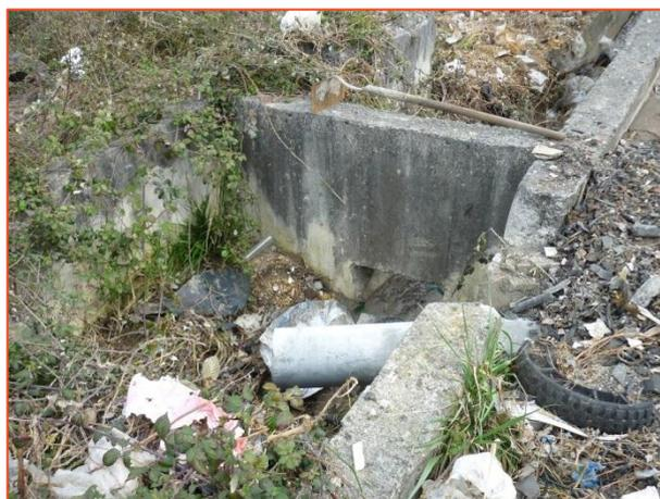
*Fotografía 8.- Canal perimetral roto y obturado favoreciendo la entrada de agua al interior del vertedero. Es imprescindible un buen mantenimiento de los mismos*
