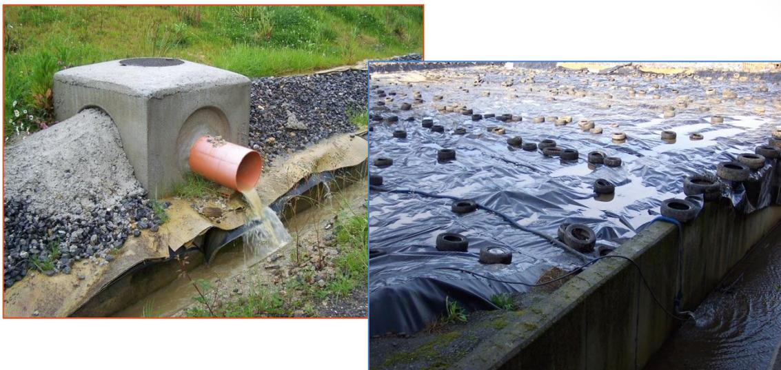
*Fotografías 14a y b.- Evacuación lateral del flujo superficial producido sobre áreas impermeabilizadas (sellado definitivo a la izquierda y cubierta provisional a la derecha)*
