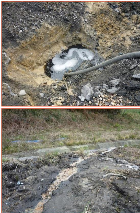
*Fotografías 17a y b.- Lixiviados sobre el vertedero evacuados mediante bombeo y lixiviados dirigiéndose a un canal perimetral*
