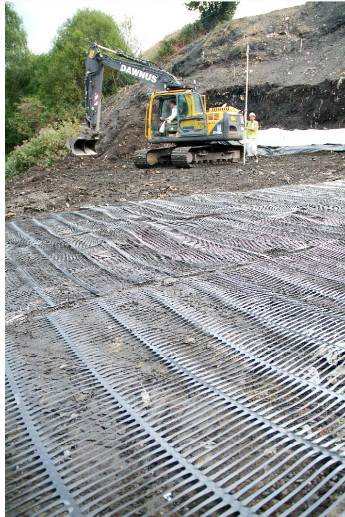
Construcción del terraplén de suelo reforzado
