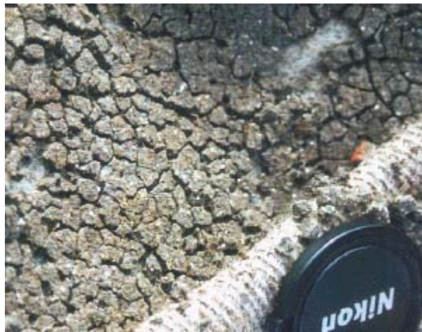
Foto 1. La bentonita dentro del geocompuesto se encontraba agrietada y seca (Benson et al. 2007)
