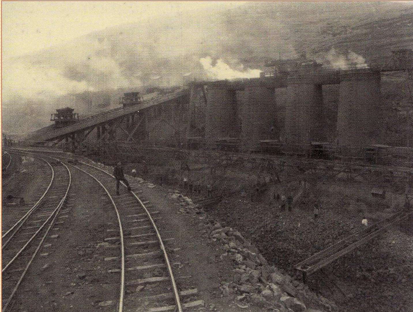
Batería de hornos de calcinación en la Estación de Orkonera (1925)
