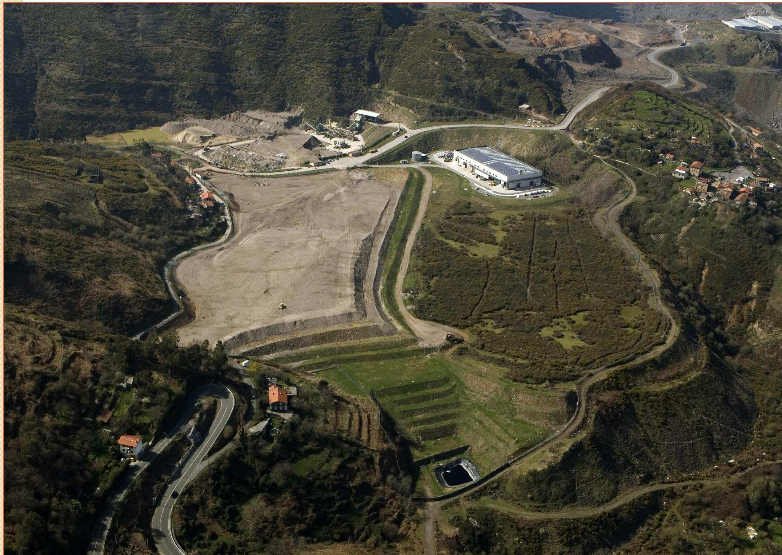
Instalaciones de Orkonera
