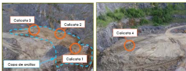
Ensayos realizados en la capa de arcillas compactadas.
