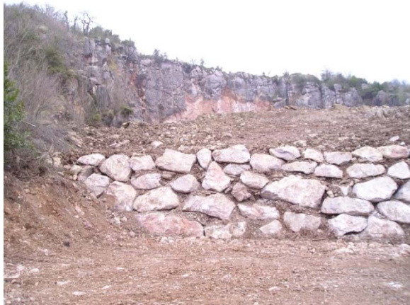
Relleno cantera de Txoritokieta, T.M. de Astigarraga.
