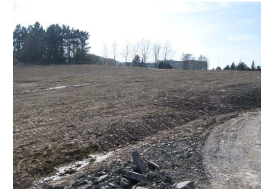
Relleno Parque Tecnológico de San Sebastián
