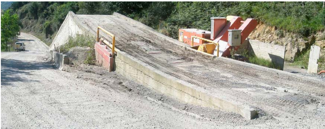
Lavarruedas de rodillos y eyección de agua a presión. Situado sobre un tramo del vial de acceso de gran pendiente ha obligado a que la rampa de salida tenga una pendiente aun mayor. En la fotografía inferior se puede ver el mismo lavarruedas visto desde abajo.
