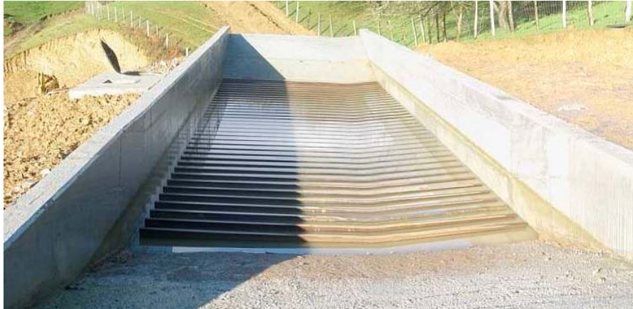
Lavarruedas construido en hormigón armado con una parrilla metálica en la base. En esta fotografía no está inundado, pero se ve la marca dejada por el agua de hasta que cota se llena.
