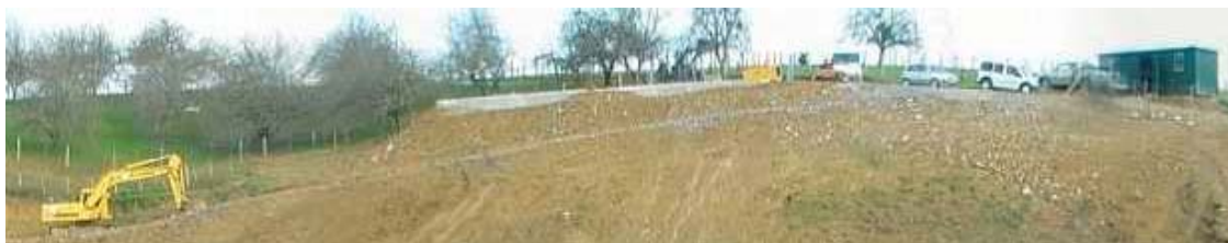
Ubicación del lavarruedas de la primera fotografía. Los camiones deben acceder a él marcha atrás. El proyecto definía el emplazamiento del lavarruedas, pero no disponía de la topografía del lugar elegido y la dirección de obra decidió instalarlo en dicho lugar, de dudosa utilidad práctica.
